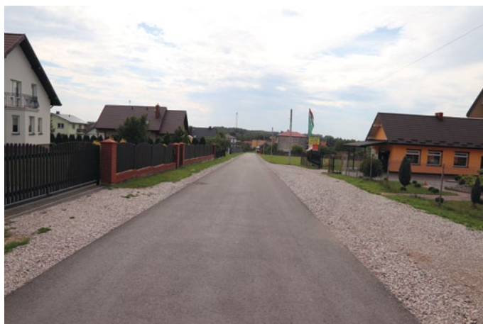
ULICA SPACEROWA W ŁOPUSZNI PO PRZEBUDOWIE
