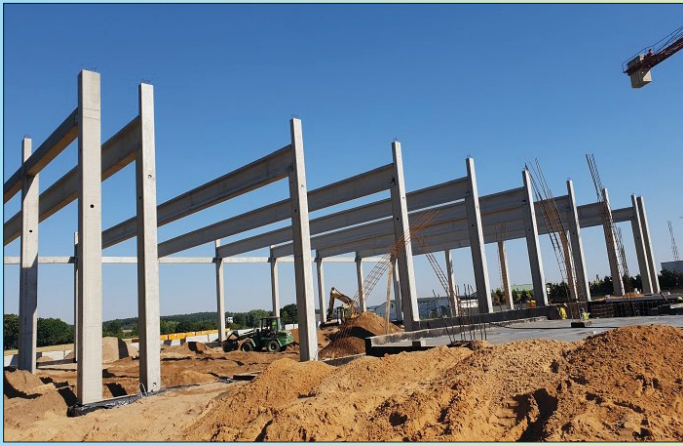
TRWAJĄ INTENSYWNE PRACE PRZY BUDOWIE NOWEJ SIEDZIBY DLA POWIATOWEGO ZESPOŁU SZKÓŁ W ŁOPUSZNI
