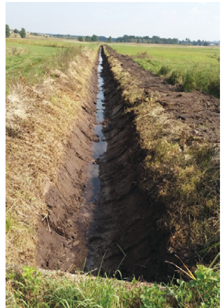
RÓW MELIORACYJNY PO WYKONANEJ KONSERWACJI W FANISŁAWICACH
