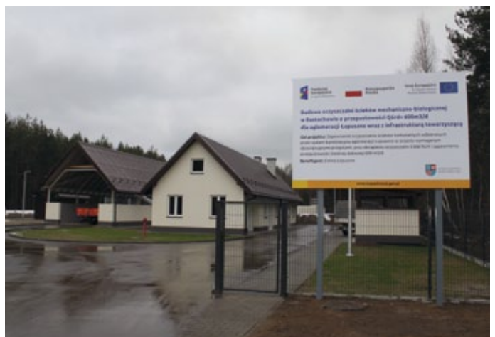
NOWO WYBUDOWANA OCZYSZCZALNIA ŚCIEKÓW W EUSTACHOWIE
