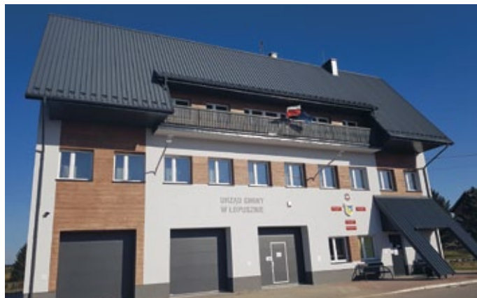
BUDYNEK URZĘDU GMINY W ŁOPUSZNIE PO TERMOMODERNIZACJI
