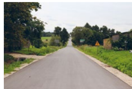
Droga Snochowice – Dobrzeszów w ramach Programu Przebudowy Dróg Lokalnych 1726 m. 662 tys. zł
