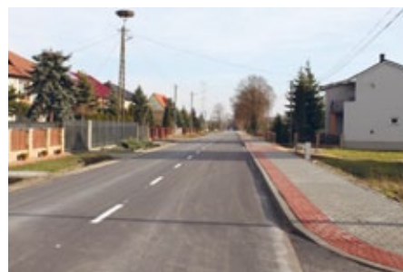
Przebudowa drogi powiatowej Nr 0484T w Gnieździskach Koszt wykonania przebudowy drogi wynosi 2 mln zł, z czego blisko 1 mln zł pochodził z dofinansowania w ramach wieloletniego programu rządowego pn. „Program rozwoju gminnej i powiatowej infrastruktury drogowej na lata 2016 – 2020”, zaś pozostała kwota 1 mln zł została poniesiona przez Gminę Łopuszno i Powiat Kielecki.
