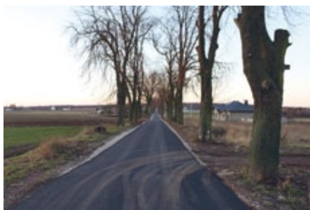
Przebudowa ul. Kasztanowej w Łopusznie wykonana w ramach PROW. Długość 950 m. Koszt 180 tys. zł
