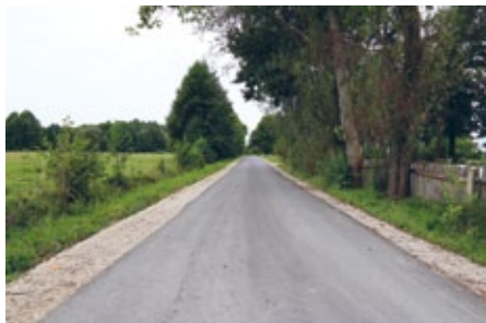
Droga gminna w Antonielowie 1138 m. 227 tys. zł
