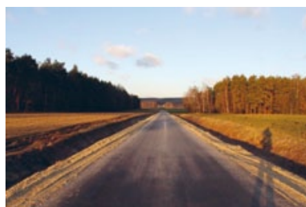
Remont drogi powiatowej Józefina- Olszówka na długości 1057 m. Koszt to 188 tys. zł sfinansowano wspólnie przez gminę i powiat po 50%
