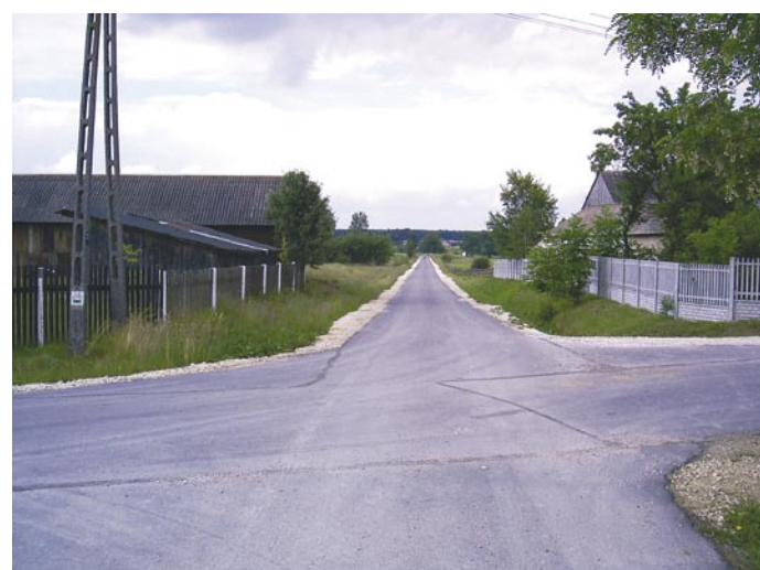
Remont ul. Dużej w Snochowicach (dł. 1450 m., data wykonania: sierpień 2007 r.)
