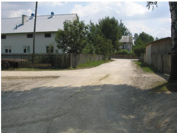
Remont drogi gminnej w Lasocinie (dł. 638 m., data wykonania: sierpień 2007 r.)
