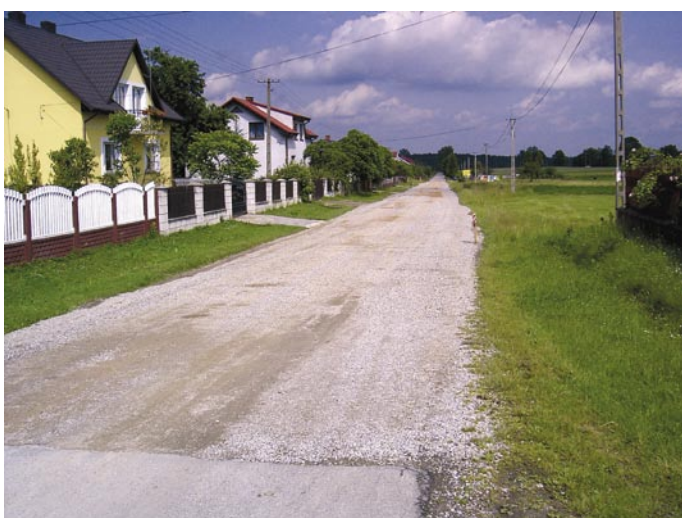
Remont ul. Małej w Snochowicach (dł. 837 m., data wykonania: czerwiec 2008 r.)
