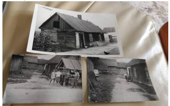
STUDNIA I FRAGMENT ZABUDOWY UL. PRZEDBORSKIEJ Z LAT 60.
