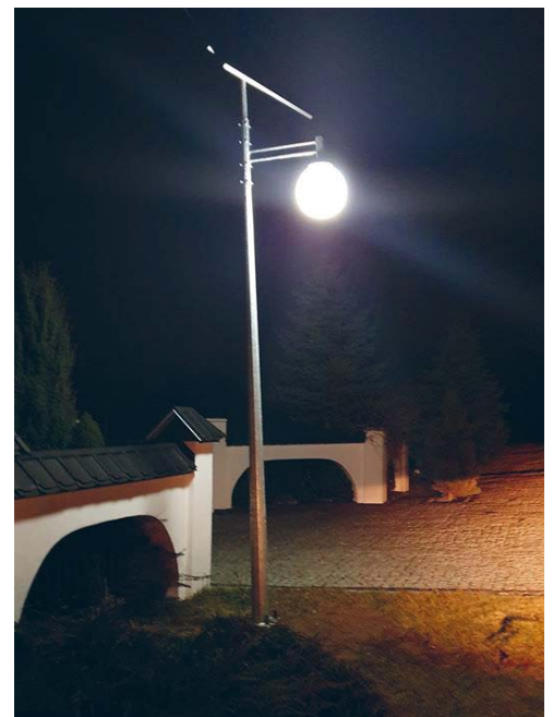
NA TERENIE GMINY ŁOPUSZNO ZAINSTALOWANE ZOSTAŁY 23 LAMPY SOLARNE
