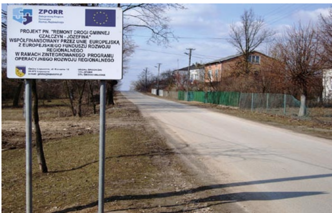
Tablica informująca o wykonaniu drogi gminnej w Józefinie przy współfinansowaniu ze środków Unii Europejskiej
