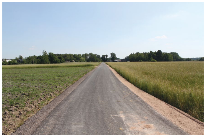
ANTONIELÓW. NOWA JEZDNIA NA ODCINKU 762MB. KOSZT INWESTYCJI WYNIÓŚŁ 169 384, 23 ZŁOTYCH
