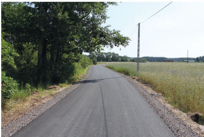
ANTONIELÓW K. CMENARZA. NOWO WYBUDOWANA DROGA NA ODCINKU 223MB. KOSZT 30 549,05 ZŁOTYCH
