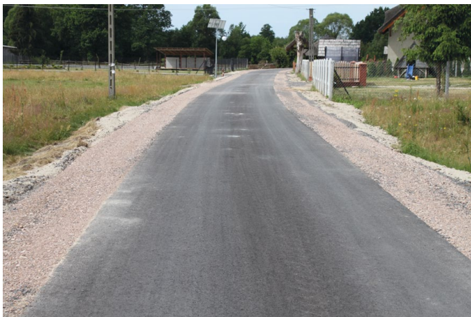
NOWO POWSTAŁA DROGA W JEDLU NA ODCINKU 879MB. KOSZT INWESTYCJI – 83 770,81 ZŁOTYCH
