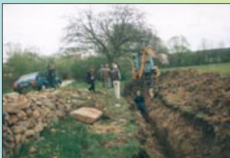
Budowa wodociągu Dobrzeszów – Podgóra
