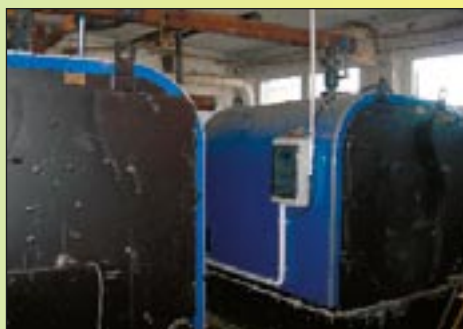
Remont pieców w Zespole Szkół w Łopusznie
