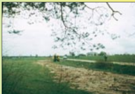
Budowa wodociągu Nowek – Dobrzeszów
